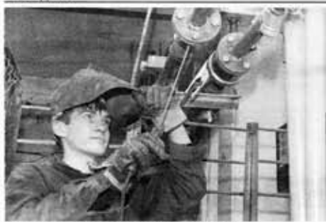
Монтаж ведёт электрогазосварщик С. Старостин
