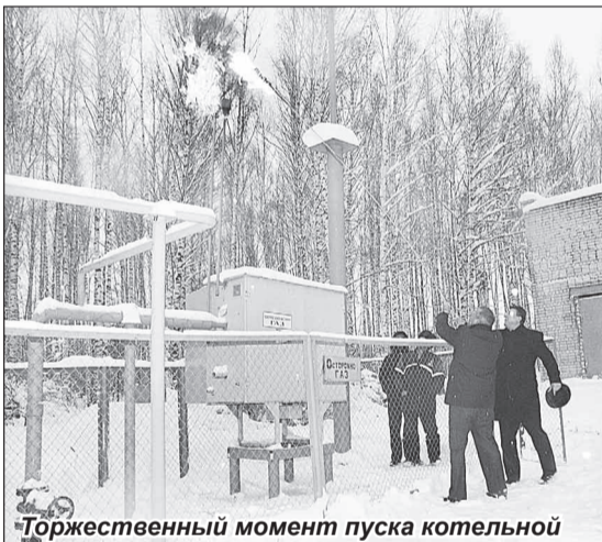
Торжественный момент пуска котельной
