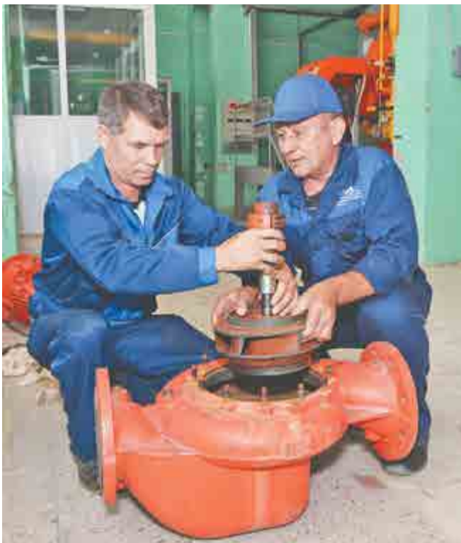
Слесари по ремонту оборудования котельных Александр Щечков и Николай Бухвалов ремонтируют циркуляционный насос водогрейного котла.
